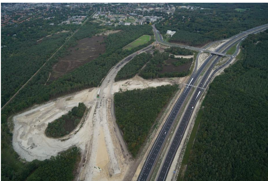
De situatie in het jaar 2018: het asfalt is verwijderd
