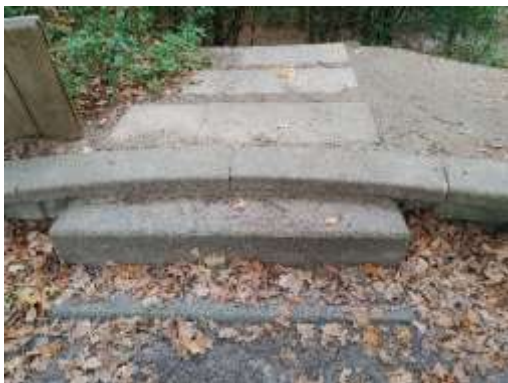
Bovenkant van de betonnen trap.
